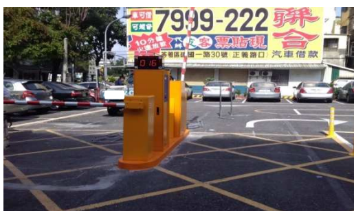
圖十一 自動柵欄機進出場管制
