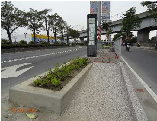
斜坡道加寬至 90 公分
