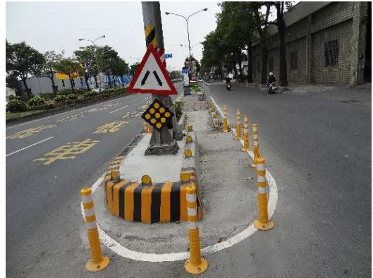
分隔島頭設置警示設施
