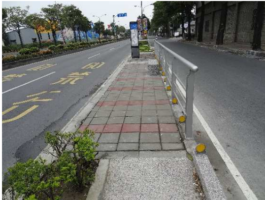
擴大候車平台及增設候車設施
