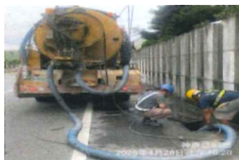
工區沿線水溝清淤
